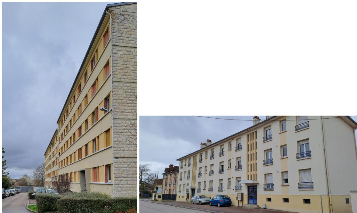
Photo 17. Bâtiments d'habitat collectif
