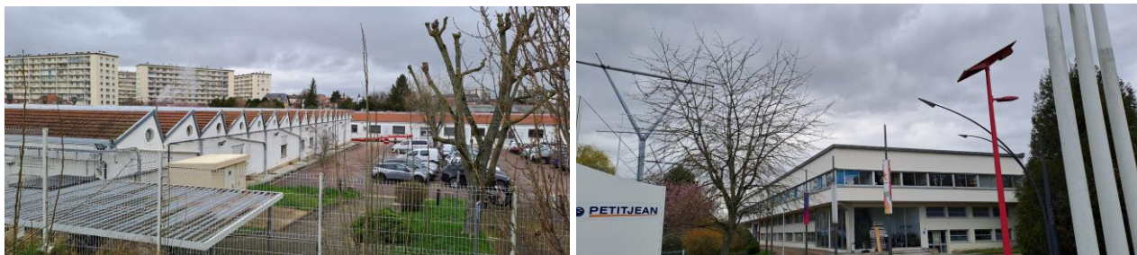
Photo 22. Bâti de type activité économique à proximité du tissu urbain ancien
