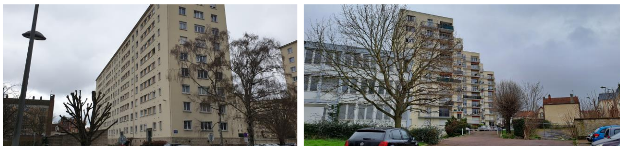
Photo 16. Bâti de type grands ensembles
